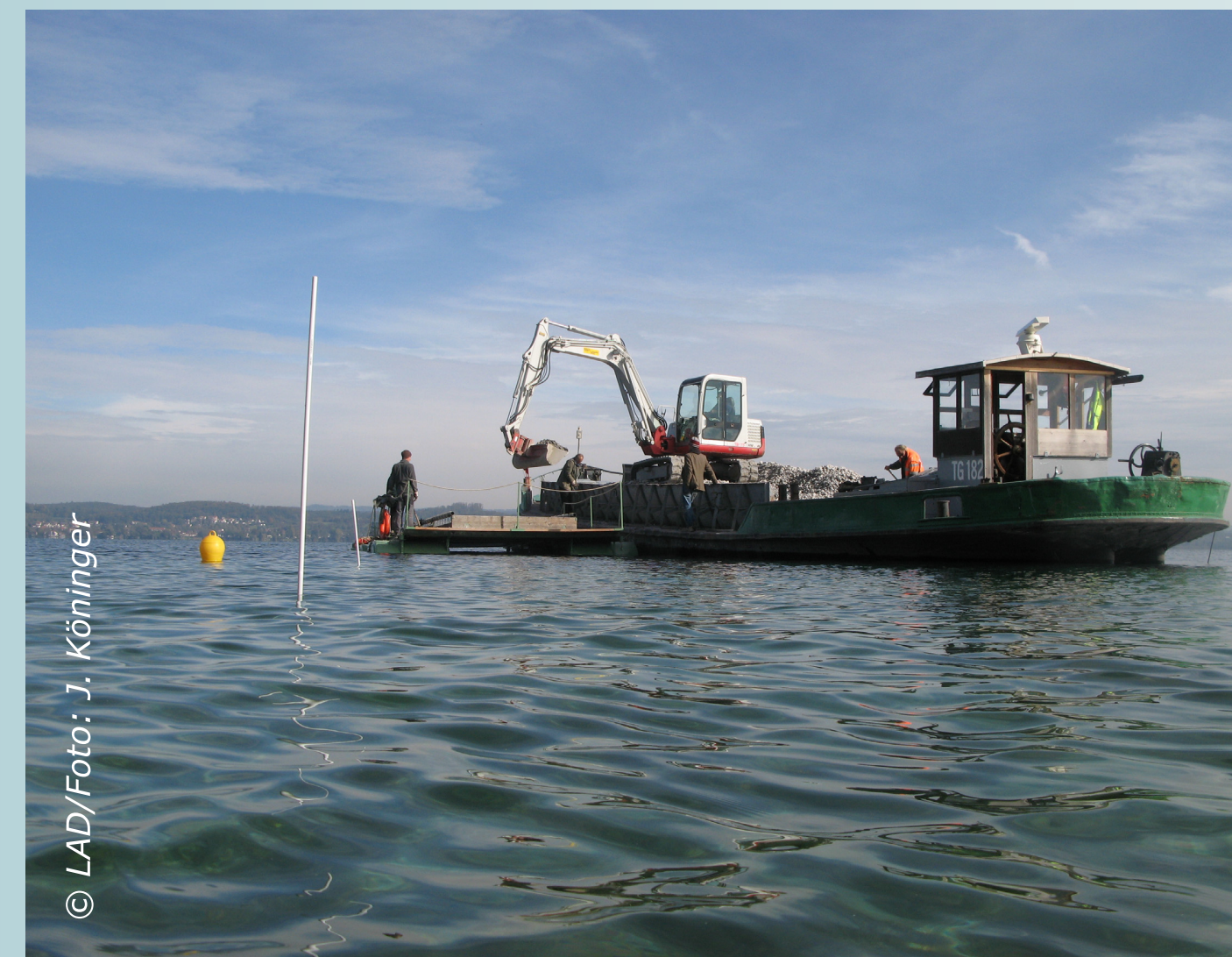
Erosionsschutz. Mit dem Kiesschiff vor Ort.
